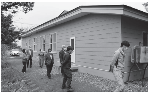
外壁など施設周辺を視察
