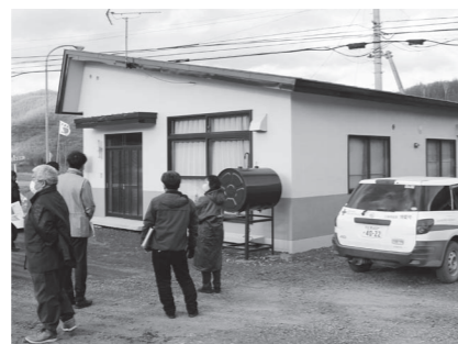
塗装工事された東公民館
