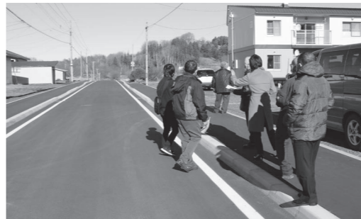
4年間の工事が完了した佐呂間30号道路
