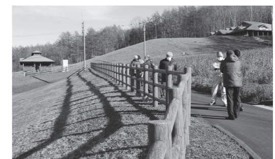
きれいに補修・塗装された木柵
