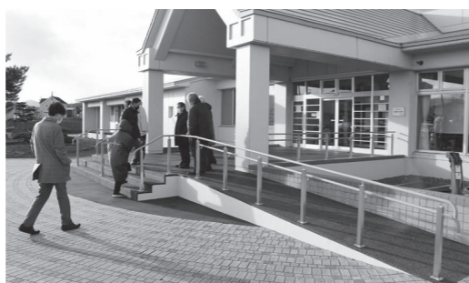
玄関付近を全面改修した若佐コミセン
