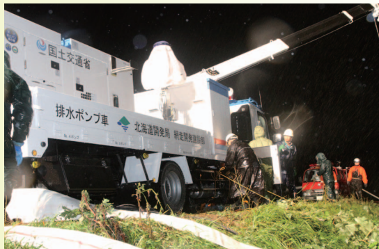
揚水車による排水作業
