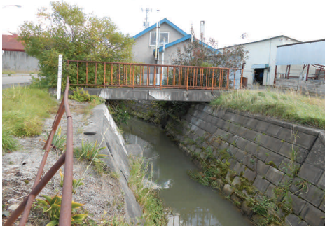
道道を横断する排水橋付近
