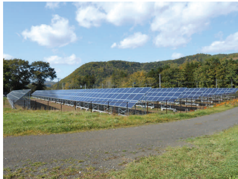
旧若佐小学校に建設されたメガソーラー
