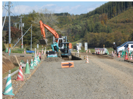
工事が進む若里基線道路
