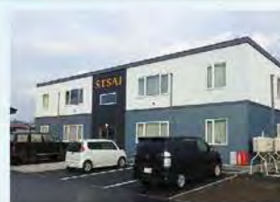
佐呂間町 職員住宅新築工事
