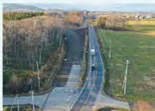
一般国道238号 佐呂間町 浪速改良外一連工事
