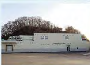
玉冷加工施設建設工事 (建築主体工事)
