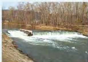
佐呂間別川 広域河川改修工事 2工区外(冬)
