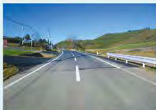
若里基線道路 改良工事
