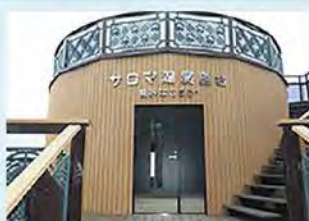
サロマ湖展望台 (休憩所)改修工事
