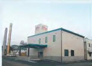
厚生棟増改築工事
