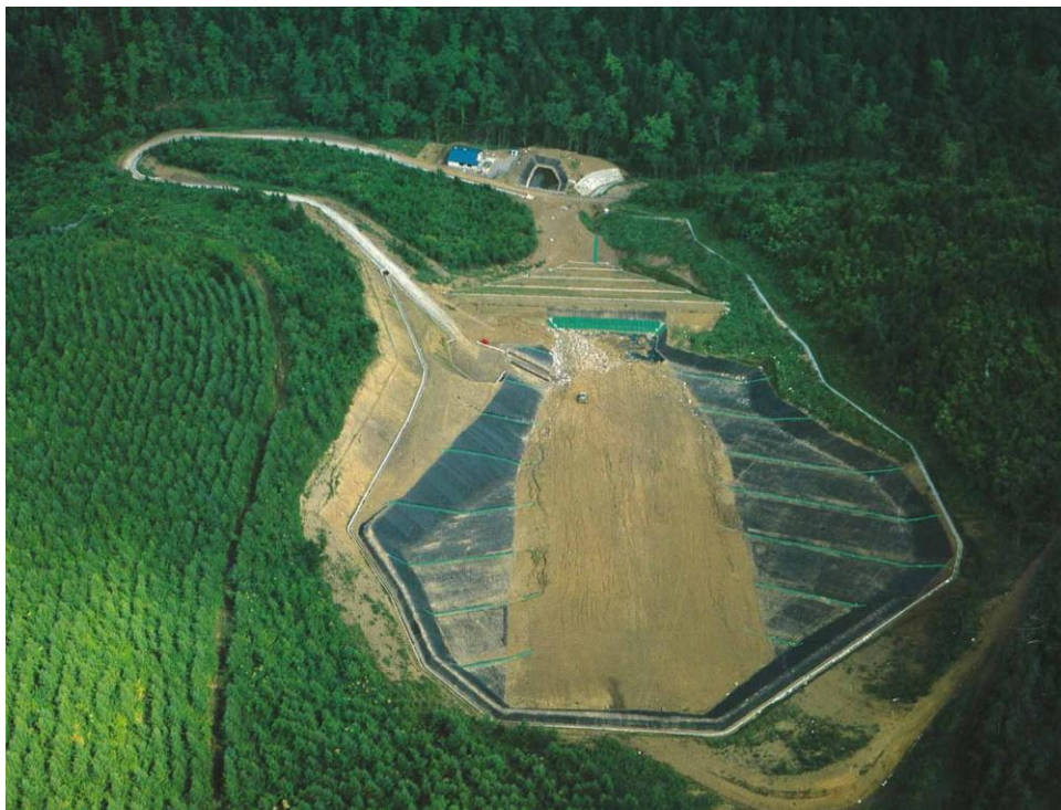
写真 3-4 佐呂間町一般廃棄物最終処分場(竣工時)
