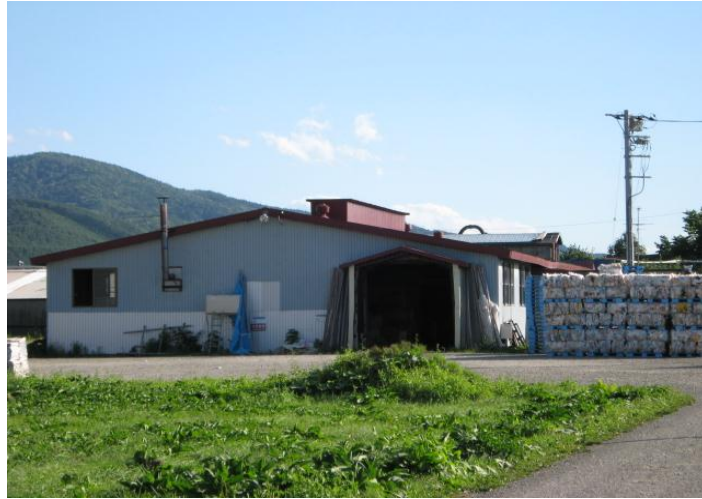
写真 3-2 遠軽地区広域組合リサイクルセンター
