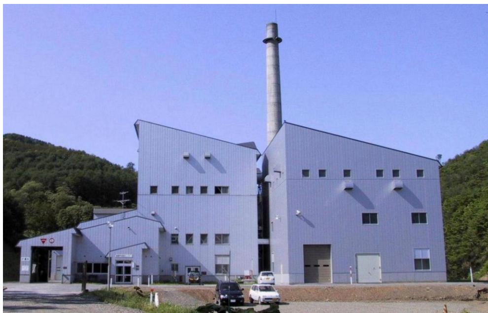
写真 3-3 遠軽町清掃センター
