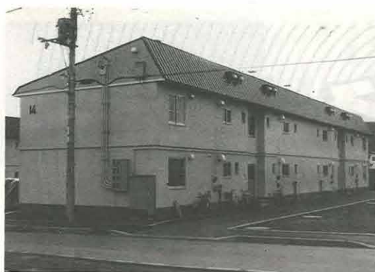
〈公営住宅新築工事〉
