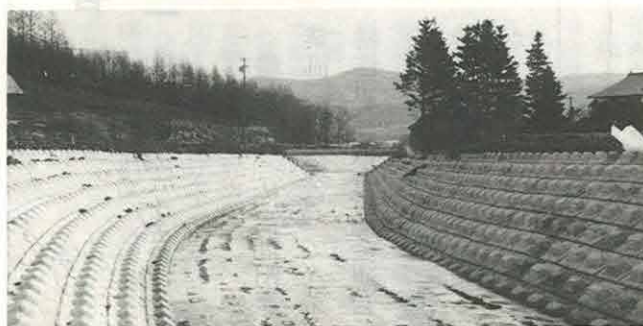
〈拓栄川災害復旧工事〉
