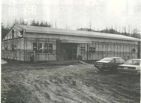
〈浜佐呂間保育所新築工事〉
