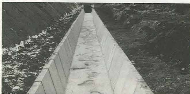
〈道営畑地帯総合土地改良事業〉（北富地区明渠排水）
