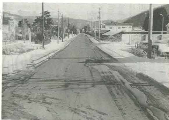
＜佐呂間7線道路災害復旧工事＞
