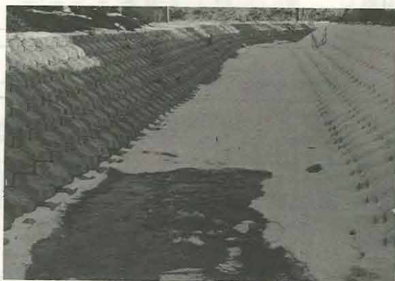
＜6号の沢川災害復旧工事＞
