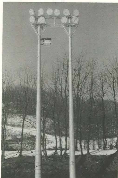
〈総合グラウンド照明施設工事〉
