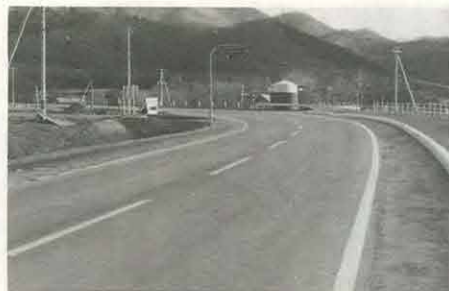
(路線が変更になった国道 333号線)
