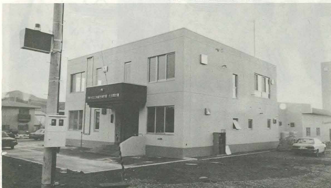
〈消防庁舎新築工事〉
