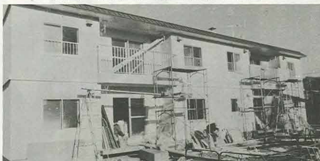
〈公営住宅新築工事（栄団地）〉
