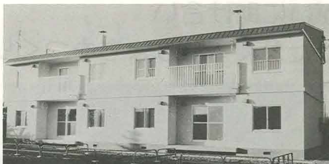
〈公営住宅新築工事（浜佐呂間第3団地）〉
