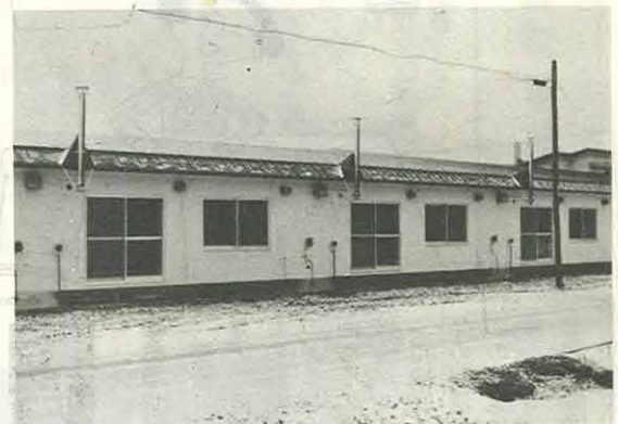
〈共済投資教員宿舍新築工事〉
