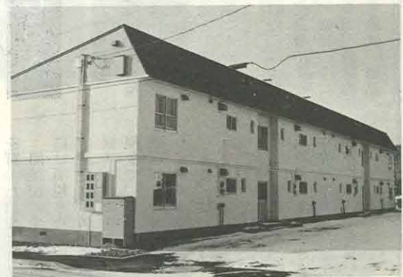
〈西富公営住宅建設工事〉
