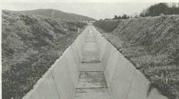
〈知来右岸地区道営排水対策工事〉
