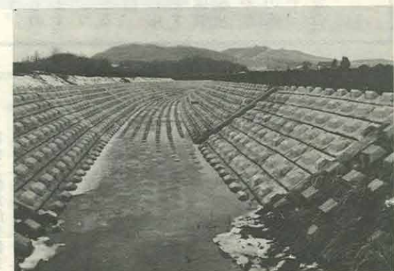
〈安斉川災害復旧工事〉
