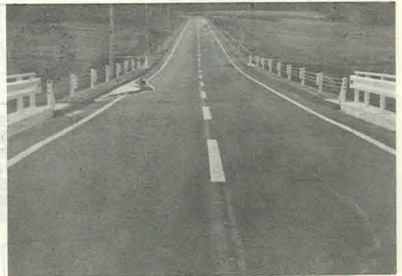
〈若里北幹線道路オーバーレイ工事〉
