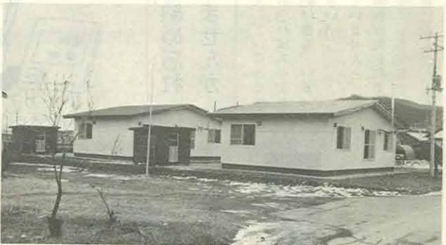
〈栄小へき地教員住宅新築工事〉
