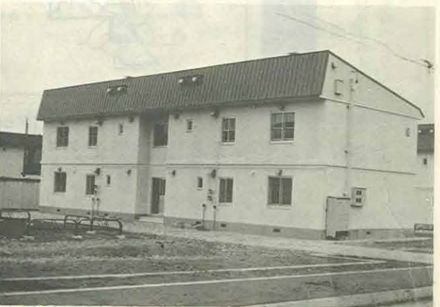
〈西富公営住宅建設工事〉
