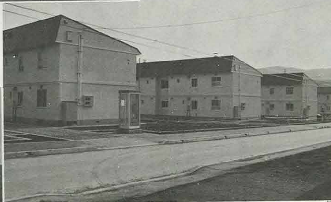
西富公営住宅新築工事 (西富)
