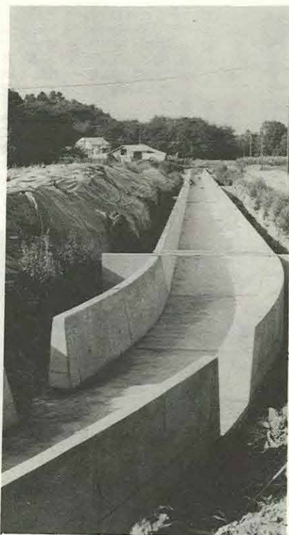
浪速地区団体営水路工災害復旧工事
