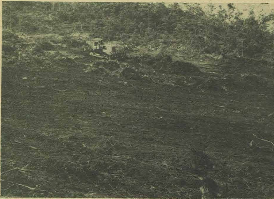
(レーキドーザーによる整地作業)
