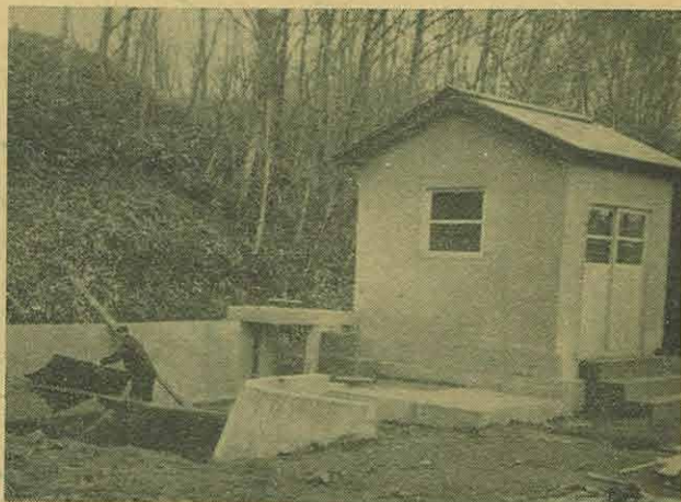
(完成した水源池)
