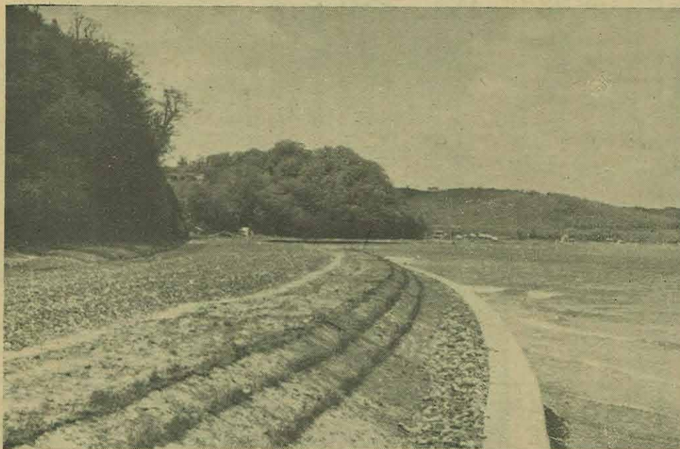
（三十七年施工の富武士地内改良工事）
