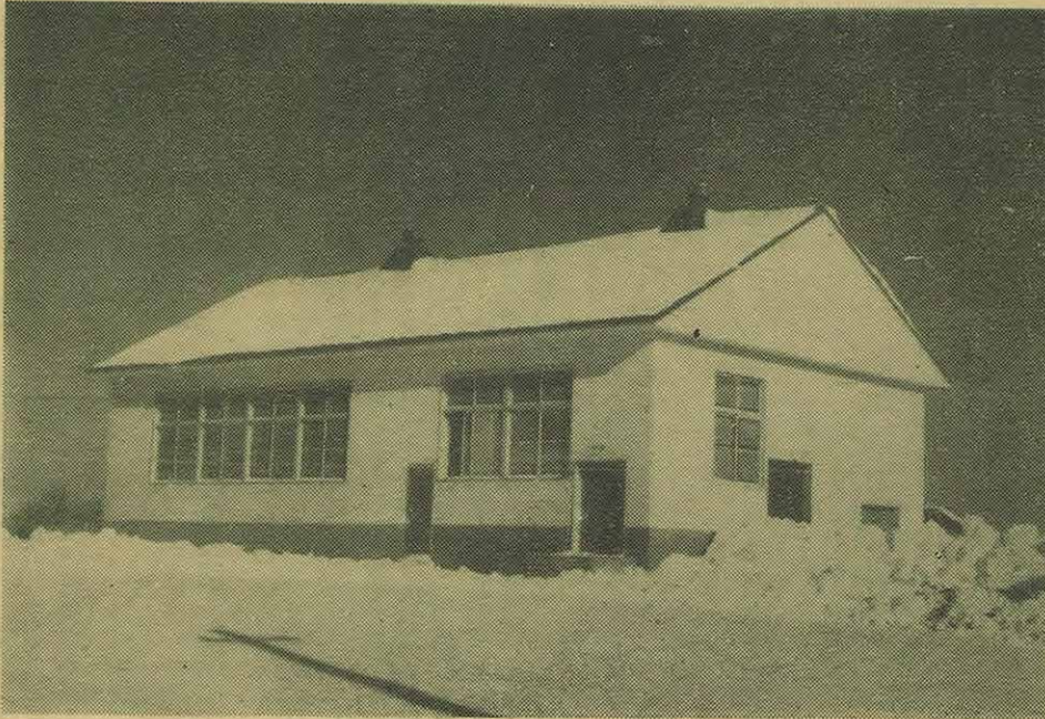
（完成した新と畜場）
