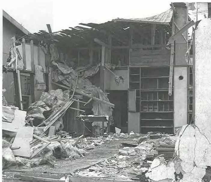
◀損壊した若佐市街地区の住宅
