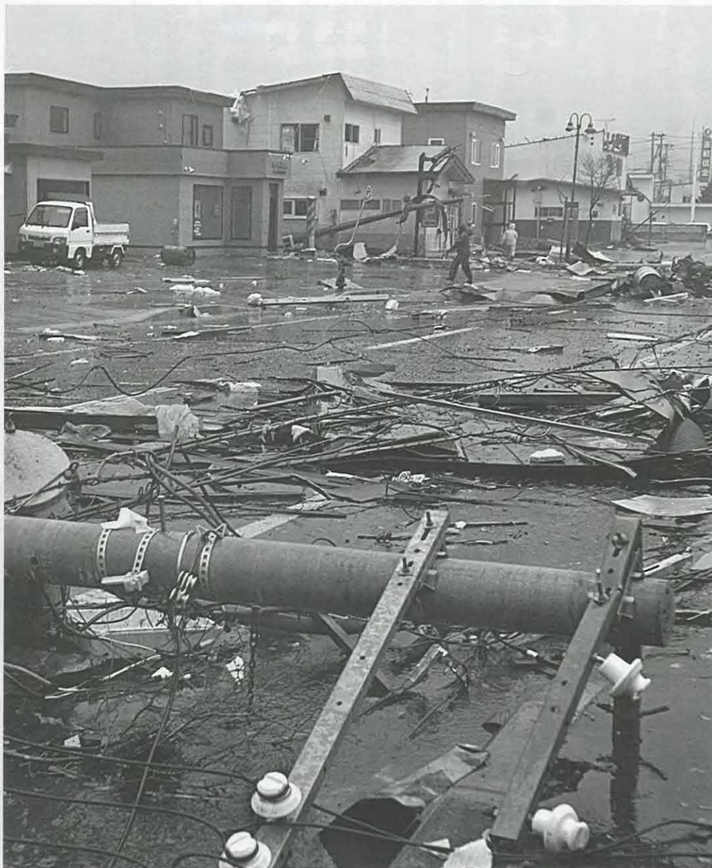
▲電柱が倒壊した若佐市街地区（道道留辺蔡・浜佐呂間線道路）
