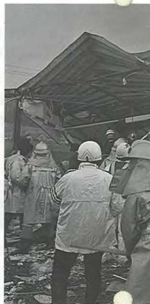
▶佐呂間消防第1分団等による救出活動（鹿島・地崎・宮坂特定企業共同体（ＪＶ）のプレハブ事務所兼作業員宿舎）
