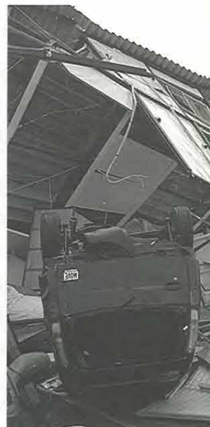
▶竜巻が直撃した鹿島・地崎・宮坂特定企業共同体（ＪＶ）のプレハブ事務所兼作業員宿舎
