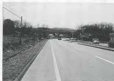
事故が遭った国道238号線
