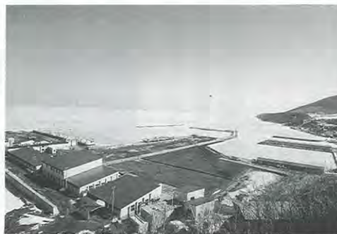
写真：整備が進む富富士漁港
