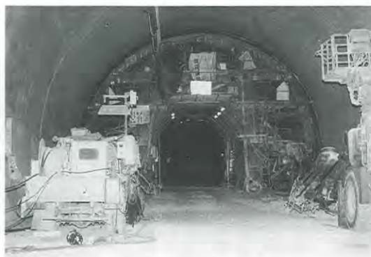
写真：旭峠のトンネル工事現場
