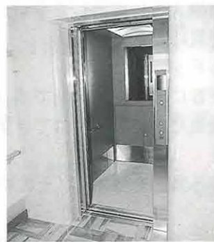
エレベータも設置
