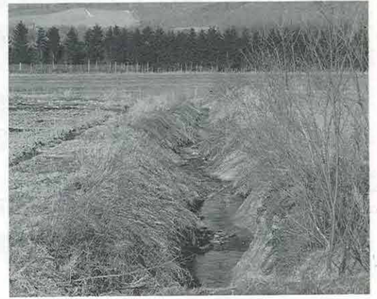
③ 道営農村地域水質保全対策事業により、伊岐武士用水路(870m)の整備工事が行われます。
