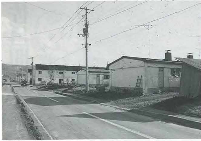
④ 古い西富公営住宅を取り壊し、一棟(八戸)新築されます。
