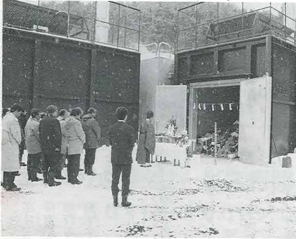
3月31日、工事関係者が出席して火入れ式が行われました。
