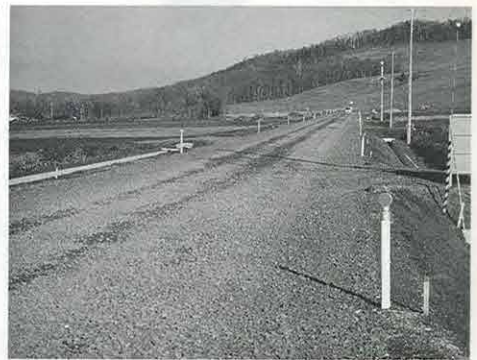
▲朝日・武士12線道路改良工事
