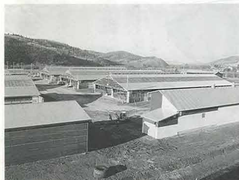
▲地域畜産活性化総合対策事業費補助金 (共同利用畜舎)
