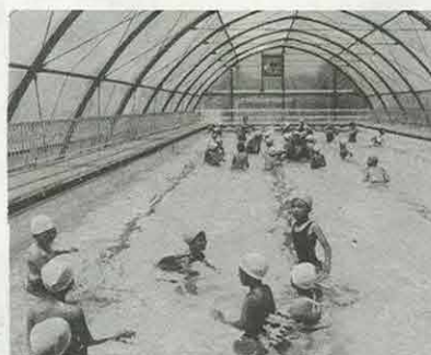
●栄小学校プール新設が完成。まちに待ったプール
