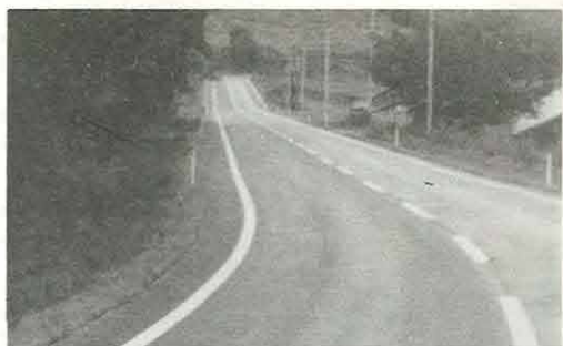
〈西富、若里幹線道路舗装工事〉
