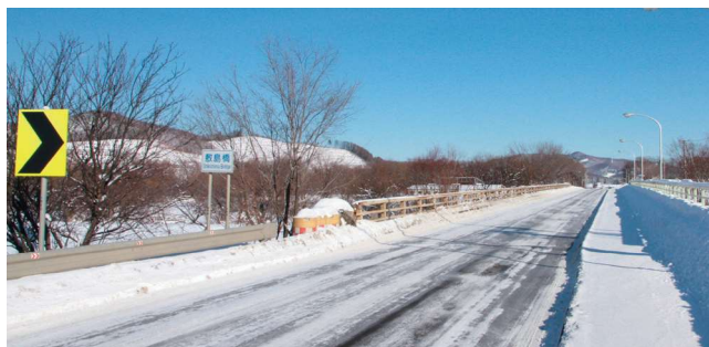
👉 国道 333 号線（敷島橋）
