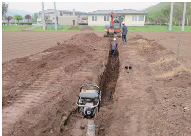
【写真：埋設作業の様子】
