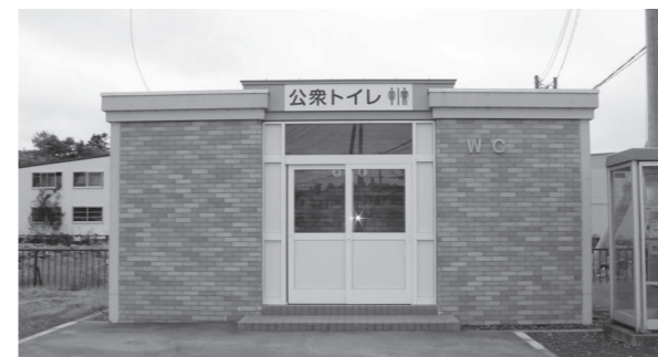
改修工事により利便性の向上した浜佐呂間公衆トイレ
