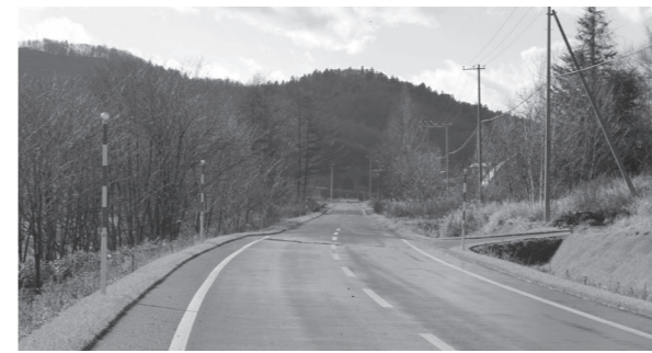
計画に基づき工事が行われている若里基線道路
