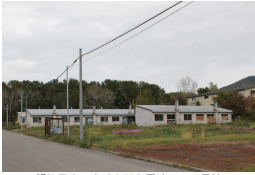
解体予定の富武士共和団地6～8号棟
