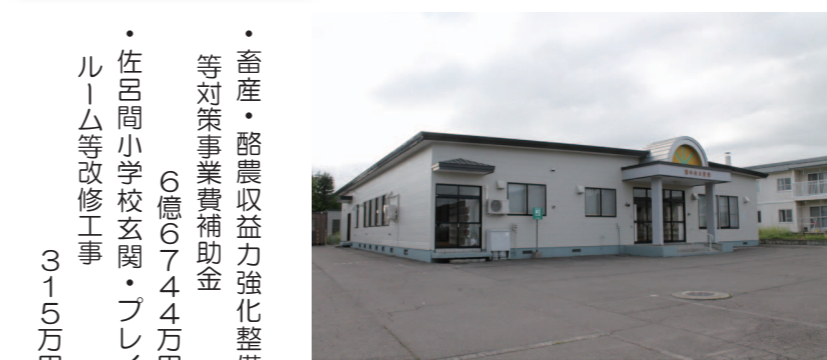
補助を受け屋根の補修を行う西中央公民館
