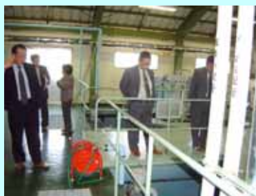
佐呂間簡易水道浄水場
