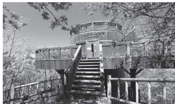
老朽化が進み改修されるサロマ湖展望台
