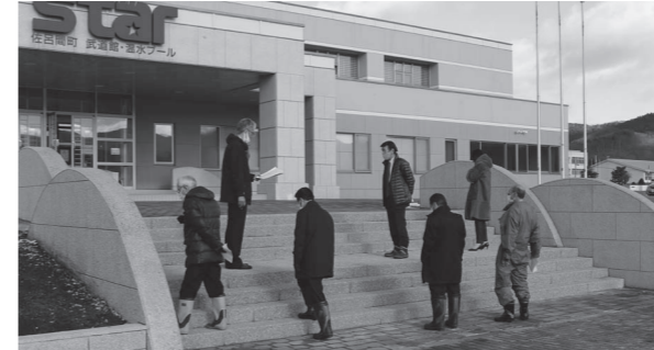
歩行者の安全確保のため改修されたスター玄関前の階段
