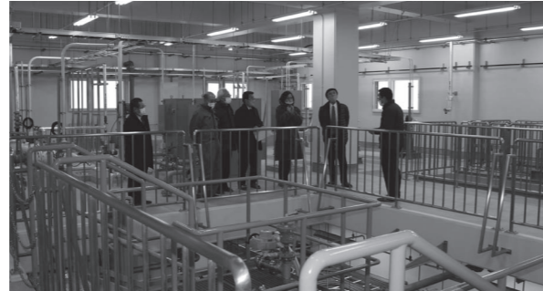
上左呂間地域と若里地区の一部の水道を賄う栃木浄水場
