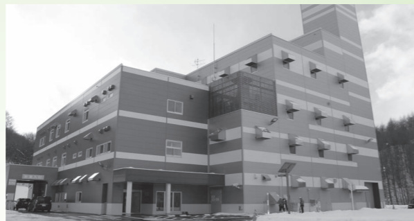
国の交付金を過大計算していた広域組合のごみ焼却施設
