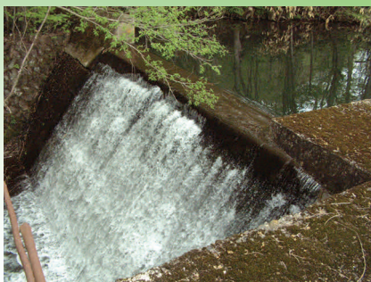
朝日にある簡易水道の取水施設
