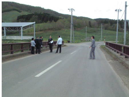
橋梁長寿命化
