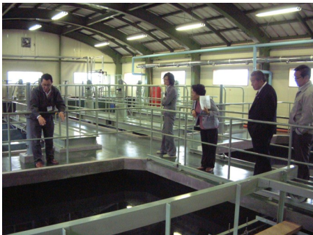
佐呂間簡易水道浄水場
