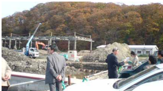
若里漁港に建設中の 養殖作業施設
